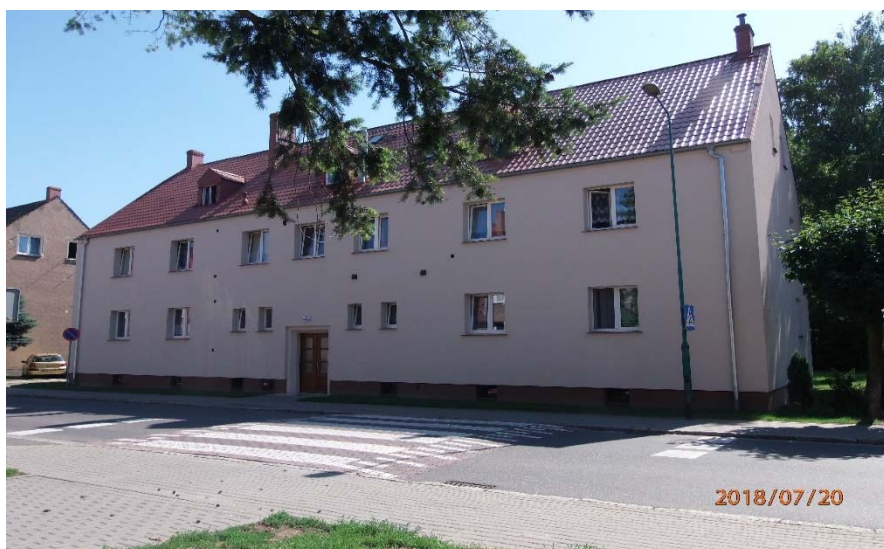
Fot. Budynek Wspólnoty Mieszkaniowej ul. Słowackiego 3
