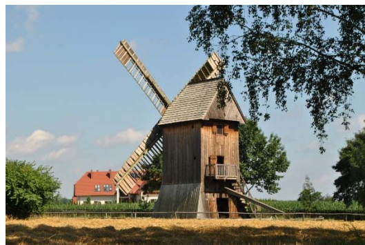
Skansen Budownictwa Ludowego Zachodniej Wielkopolski, wiatrak koźlak z
