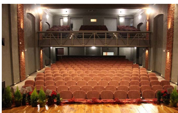
11.12.2014 Sala widowiskowa po remoncie
