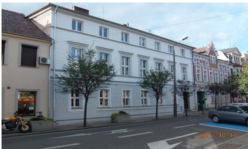
Fot. Budynek Komunalny ul. 5 Stycznia 26.
